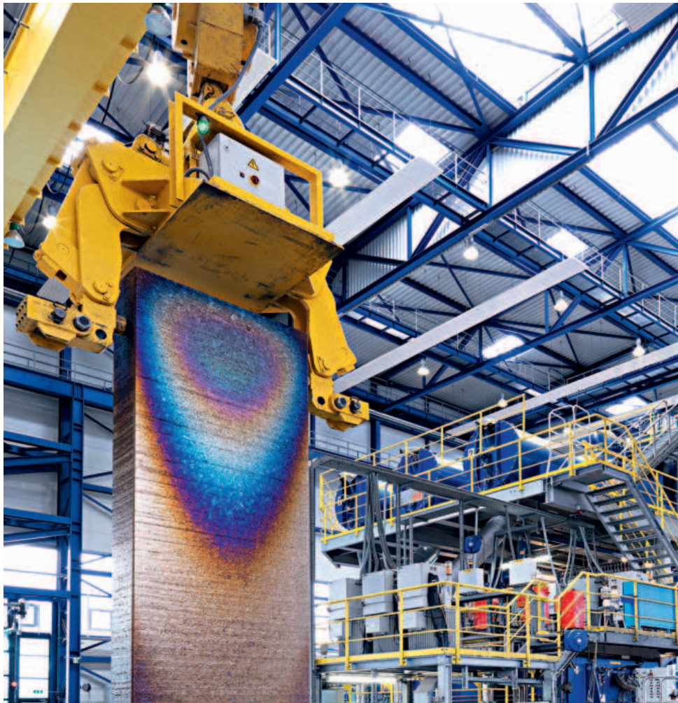
Die Abbildung zeigt die erst kürzlich neu erbaute Halle 1 mit herkömmlichem Licht. Alle Hallen werden sukzessive auf neue LED-Lichtbänder umgerüstet.
